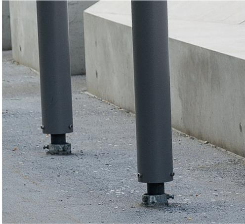
Drehlagerung für Mastrohre.
