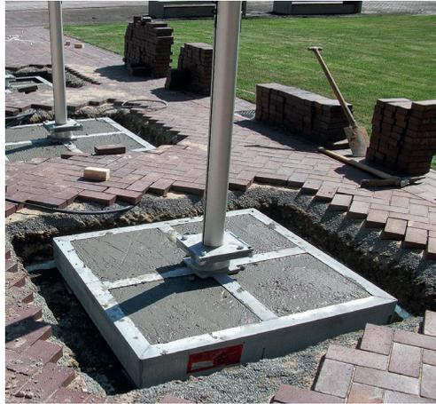
Stahlrahmen zur Fundamentverbreiterung für „schwimmenden“ Einbau auf Tiefgaragen.
