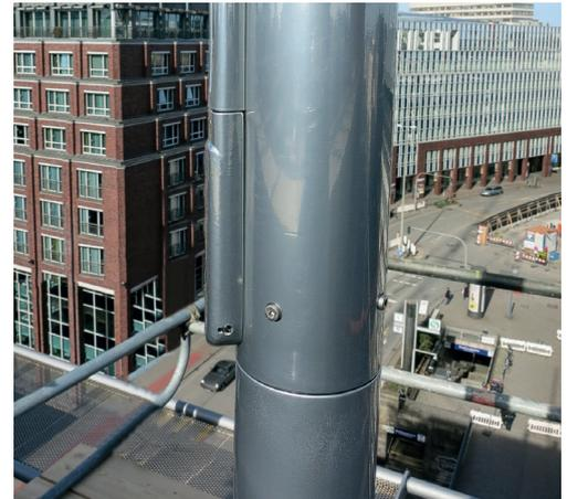
Mastrohr 2-teilig mit Drehlagerung, Fassadenmontage
